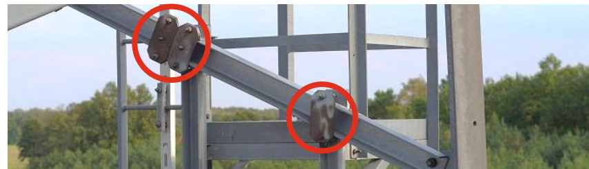
Foto. 1. Elementos corroídos identificados
